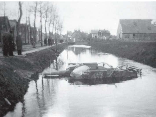
Een tank in de Boomvaart in Steenberg | © archief Ad van de Poer
