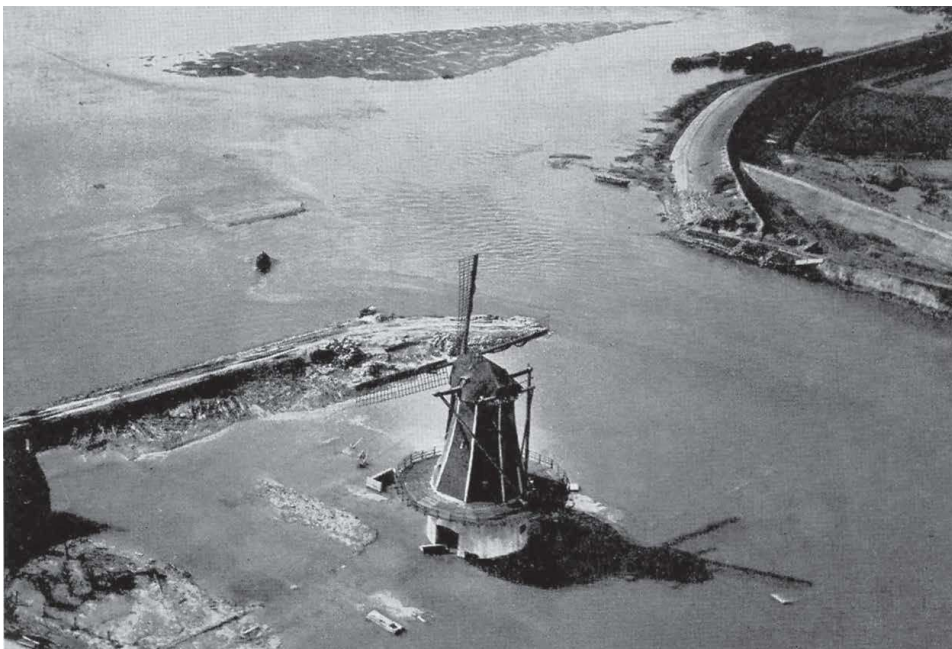
Het zogenaamde Molengat dat met hulp van honderden mensen wordt gedicht | © Wateraanloodmuseum
