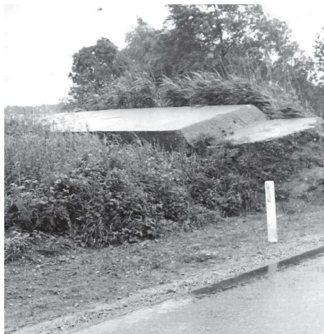
Een tankmuur aan de Moerstraatweg in Welberg
